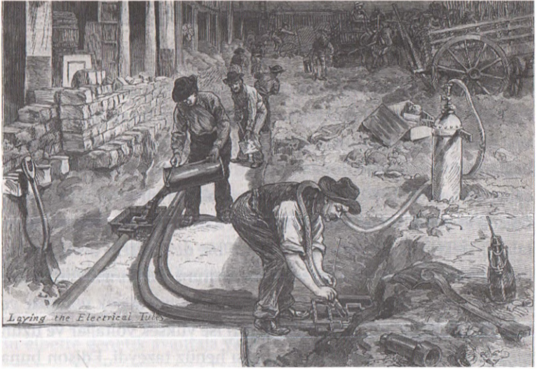
Resim 9.3: 21 Haziran 1882 tarihli Harper's Weekly dergisinde yer alan "The Electric Light in Houses: Laying the Tubes for Wires in the Streets of New York" (Evlerde Elektrik Işığı: New York Sokaklarına Kablo Boruları Döşenirken) adlı makaleye ait bir çizimden alıntı. Edison kabloları direklerle germek yerine yeraltına gömmeyi tercih etmişti.
